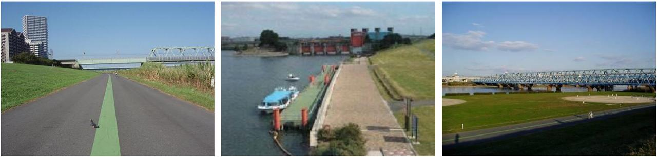
図-2 河川防災施設（緊急用河川敷道路・緊急用船着場・高水敷）
