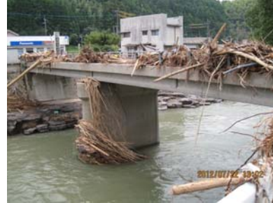
地滑りにより形成された天然ダム(八女市星野村) 流木で被災した宮ノ原橋(八女市上陽町)
