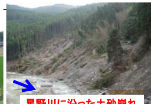
星野川に沿った土砂崩れ(上陽町久木原)
