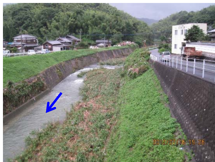
矢部川に合流する白木川(右岸側から氾濫し、八女市立花町北山山下地区が浸水した)
