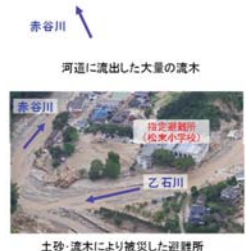
土砂・流木により被災した避難所
