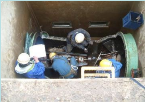
(ポンプ設備の点検・整備)
