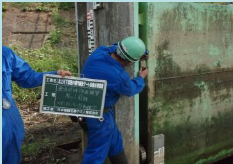
(ゲート設備の点検・整備)
