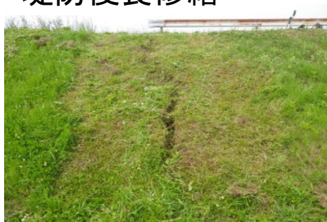
堤防侵食修繕
