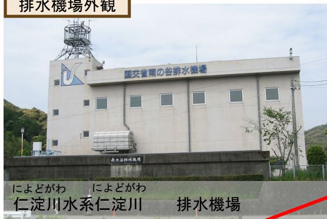
排水機場外観
