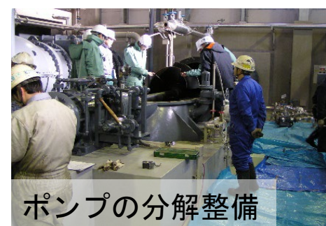
ポンプ設備の整備
