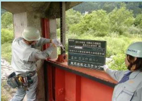
(樋管ゲートの点検)
