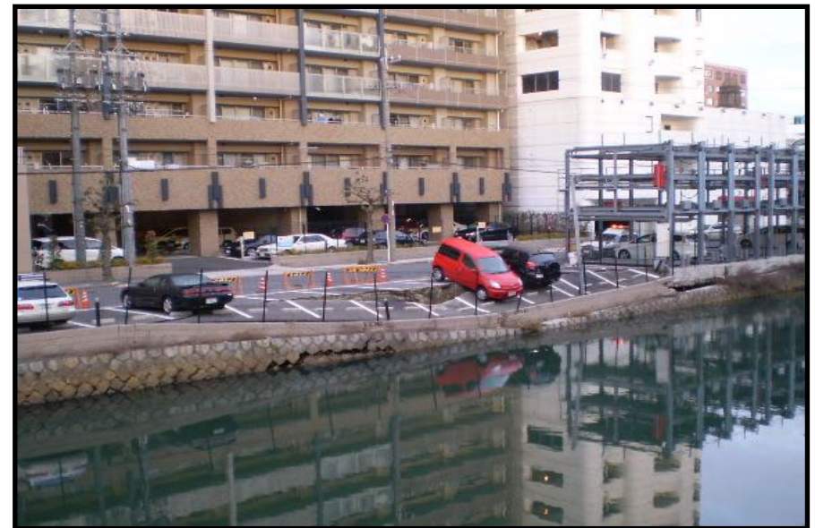
鋼矢板基礎の損壊状況
