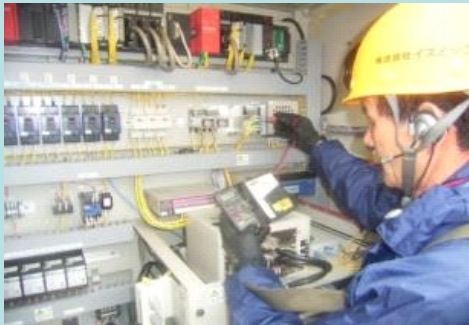
(機械設備の点検)
