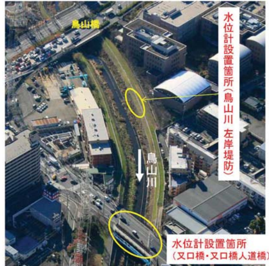
水位計設置箇所
