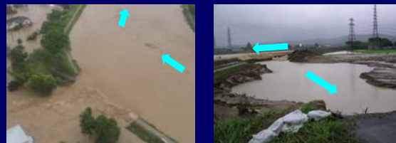
刈谷田川左岸の破堤 五十嵐川左岸の破堤 2004年7月新潟・福島豪雨
