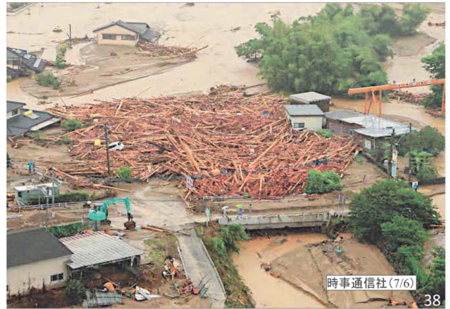
北川・本陣橋付近に集積して河道を閉塞した流木(土砂流氾濫の原因となる)
