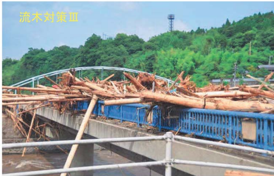
平成24年九州北部豪雨での玉来川 越水部分下流の阿蔵新橋に集積した大量の流木
