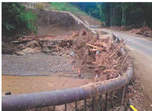
黒川の佐田川への合流点 洪水直後 (橋梁部で流木により河道が閉塞)
