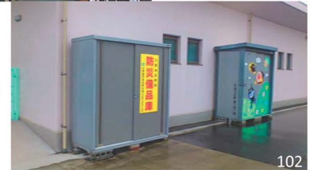
小学校に設置された備蓄倉庫
