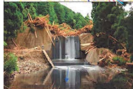
須川第一砂防堰堤下流から木取を撮影
