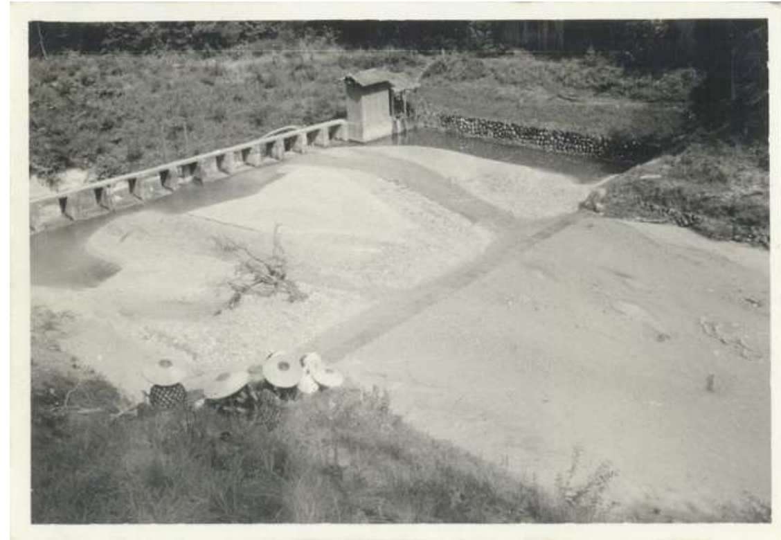
昭和33（1958）年8月25～26日台風17号白坂堰堤土砂流入状況。奥の小屋に水位計が設置されている （昭和33年9月6日撮影、生態水文学研究所アーカイブス）
