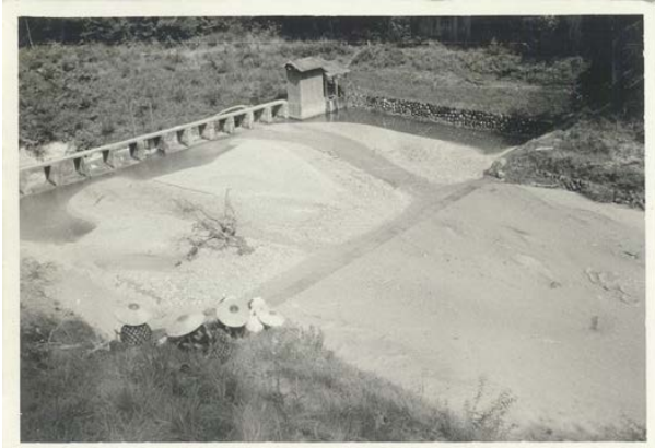
図-5 昭和33（1958）年8月25～26日台風17号白坂堰堤土砂流入状況。奥の小屋に水位計が設置されている（昭和33年9月6日撮影、生態水文学研究所アーカイブス）
