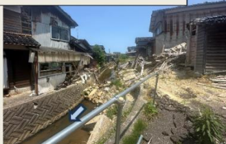
瓦礫による河道の閉塞～蛸島川～
