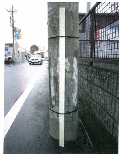
図-8 浸水センサー設置の様子
