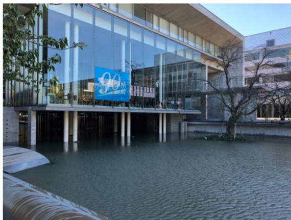
SAKURA センター浸水状況 (10/13 撮影)
