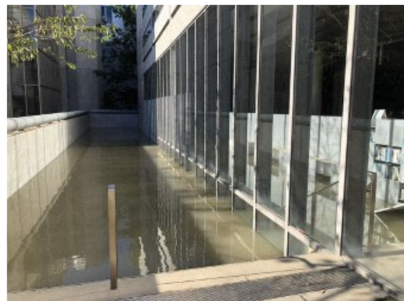
図書館地下浸水状況
