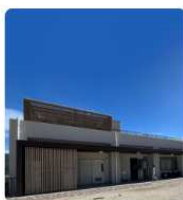
広島市豪雨災害伝承館
