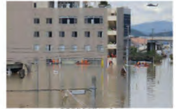
真備高松倉庫センター (老人保健施設ライフタウンまじ)
