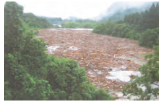
妙見川砂防ダム
