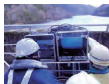
ロボット操作状況
