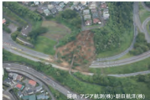
逗子ICにおけるのり面崩落 (神奈川県逗子市)
