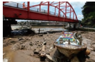
港湾への土砂流入 (静岡県熱海港伊豆山地区)
