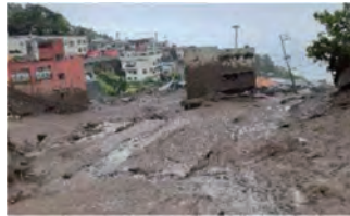
土石流による被害 (静岡県熱海市)
