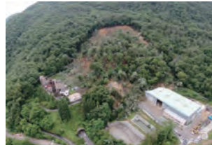
地すべりによる被害 (長野県長野市)
