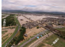
⑤小田川における浸水被害 (岡山県倉敷市)
