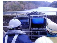
ロボット操作状況
