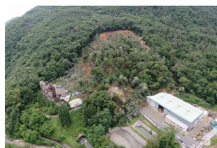
地すべりによる被害 (長野県長野市)
