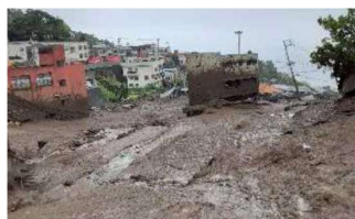
土石流による被害 (静岡県熱海市)
