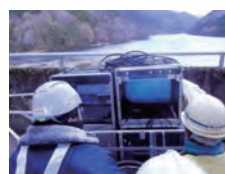
ロボット操作状況
