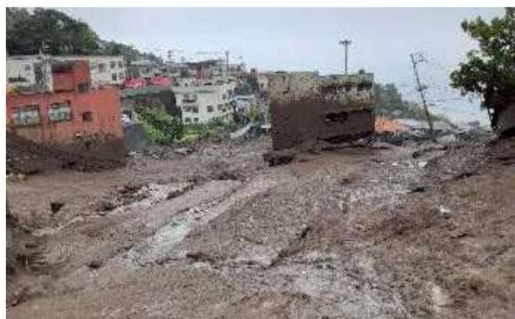
土石流による被害 (静岡県熱海市)
