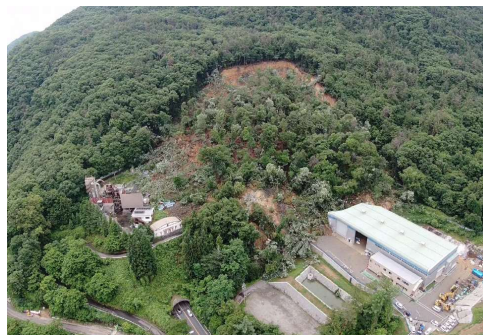
地すべりによる被害 (長野県長野市)
