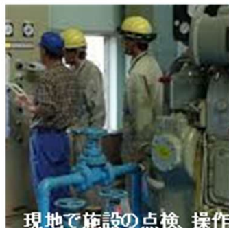
現地で施設の点検、操作
