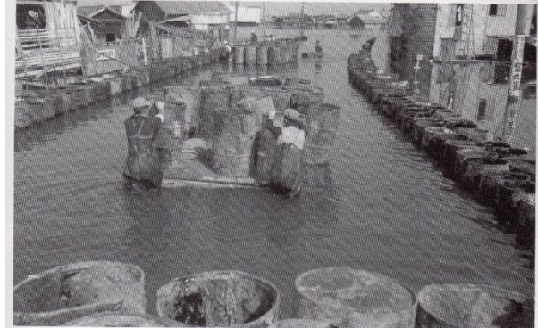
道路の复旧にドラム缶1万本をかり集めた「ドラム缶工法」(蟹江-鈴富間) 写真提供: 中川区
