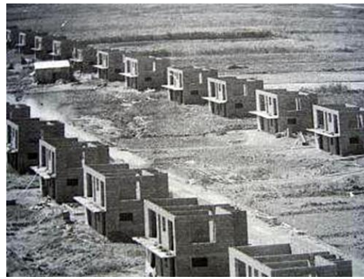
水害対策万全の3階建てコンクリート復興住宅の建設(1960-62)
