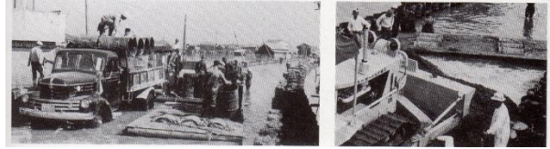
道路の复旧にドラム缶1万本をかり集めた「ドラム缶工法」(蟹江-鈴富間) 写真提供: 中川区
