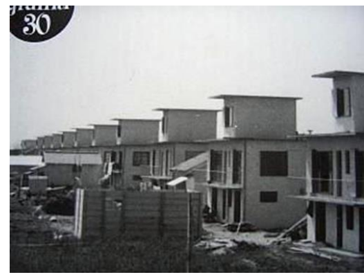
水害対策万全の3階建てコンクリート復興住宅の建設(1960-62)
