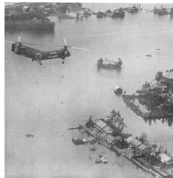
水中に孤立した盛土上の家屋 (旧長島町)
