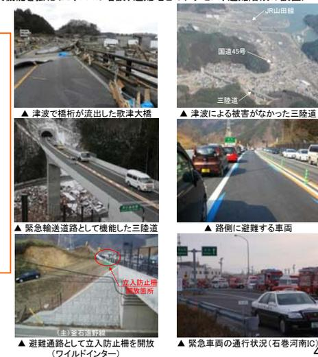
▲津波で橋桁が流出した歌津大橋
