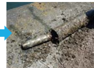
貝等を除去したセンサー部
