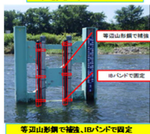
等辺山形鋼で補強、IBバンドで固定
