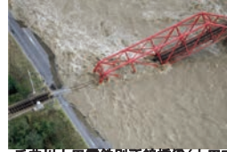
千曲川上田電鉄別所線橋梁(上田市)
