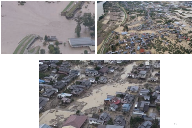
2019.10 台風19号による千曲川(穂保地区)破堤
