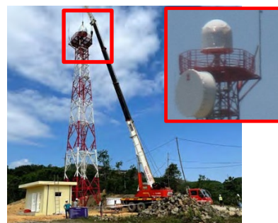
雨量レーダの設置工事状況
