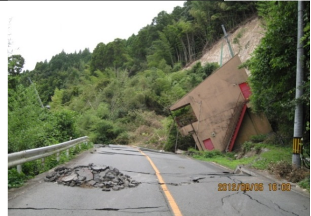
道路沿いの土砂崩れ(星野村柳原)
