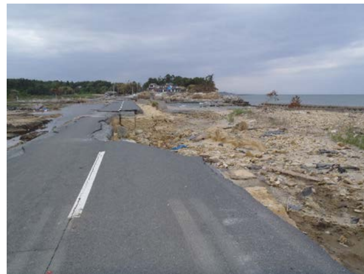
南相馬道路被災状況
