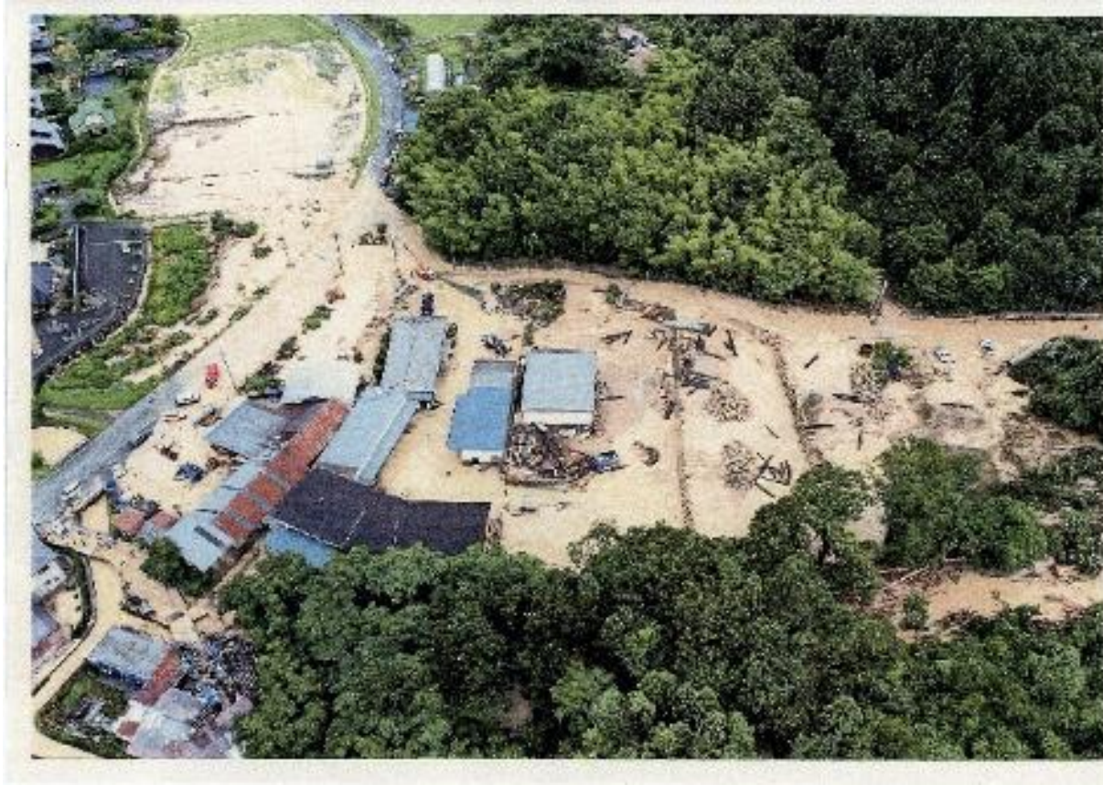
滋賀県高島市拝戸の被災状況 （(株)前河建設 提供）
