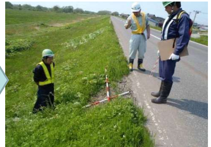
◆堤防除草後の職員等による堤防点検
