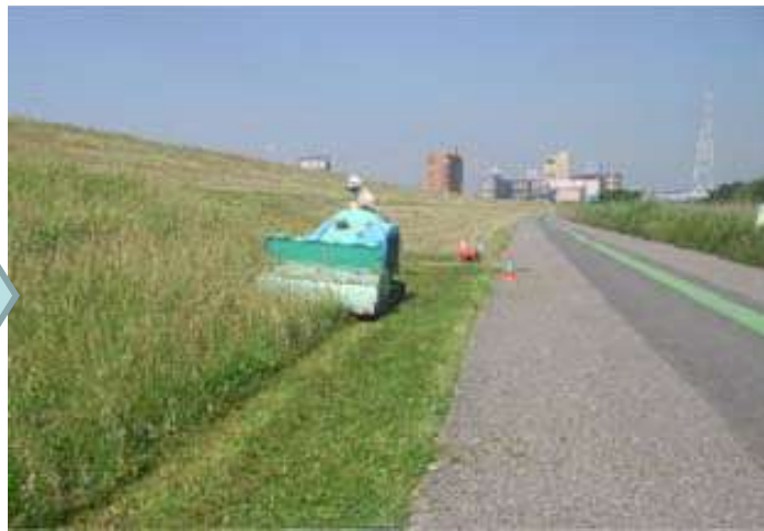
◆堤防点検等のため堤防除草を実施
