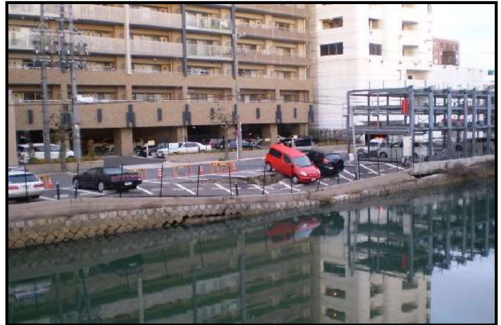
鋼矢板基礎の損壊状況
