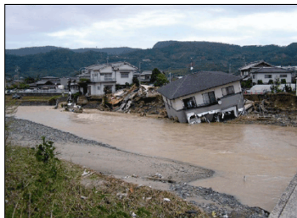
図-6 H16台風23号 香川県本津川の氾濫後の状況 2)
